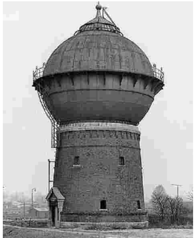
Figura 9 Becher, serbatoio d'acqua (water tower) , Crailsheim, Germany, 1979.
